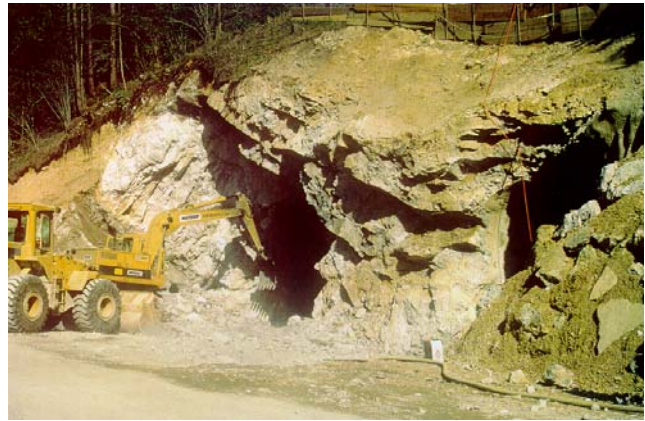
Ausbruch der Leitungsstollen zu den Klärbeckenkavernen
