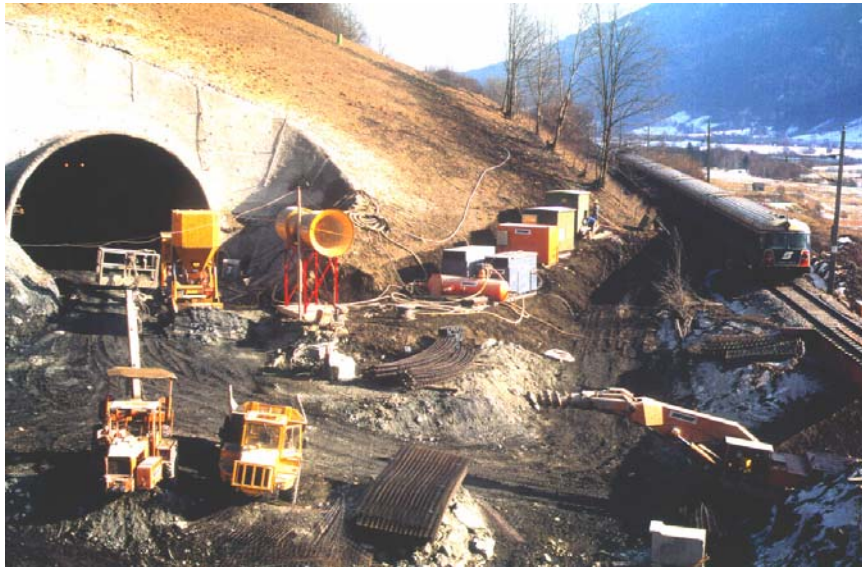
Tunnelvortrieb bei Aufrechterhaltung des Bahnbetriebs am Bestand
