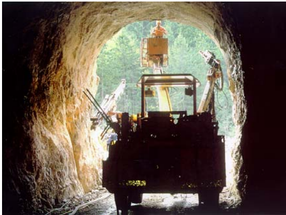
Ausbruch der Leitungsstollen zu den Klärbeckenkavernen
