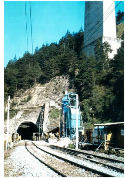
Baustelleneinrichtung am Südportal
