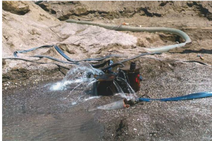
Gespanntes Grundwasser an einem Absenkbrunnen
