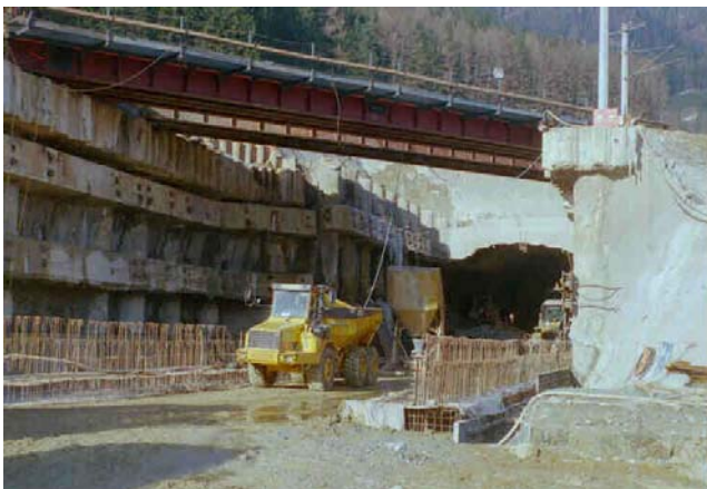
Komplexer Anfahrbereich mit Unterquerung der ÖBB-Südbahnstrecke (Bohrpfahlwände und Luftbogenstrecke)
