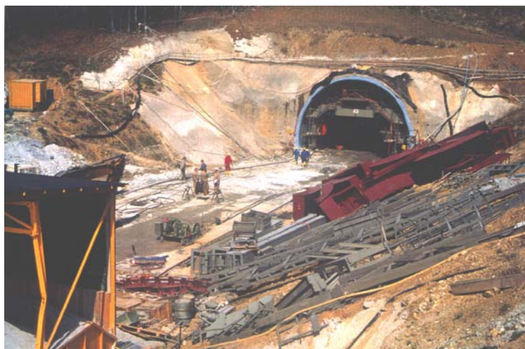
Voreinschnitt Westportal, Einrichtung des Schalwagens für den Innenbeton
