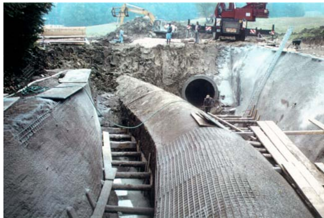
Zielschacht, Anbindung an den Bestand der II. Wiener Hochquellenleitung
