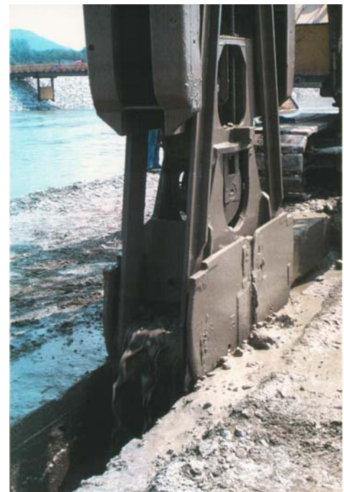
Abteufen einer Schlitzwandabdichtung
