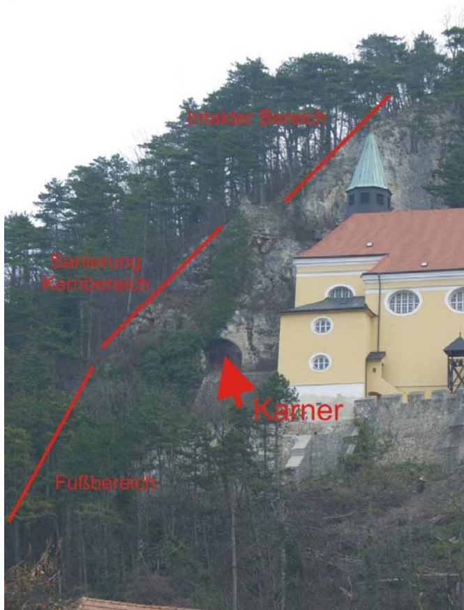
Übersichtsaufnahme mit Eintragung der wesentlichen Abschnitte bzw. Problembereiche
