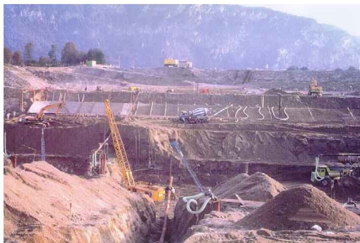
Baugrube für die Staustufe nach Erreichen der tiefsten Aushubsohle (September 1989)
