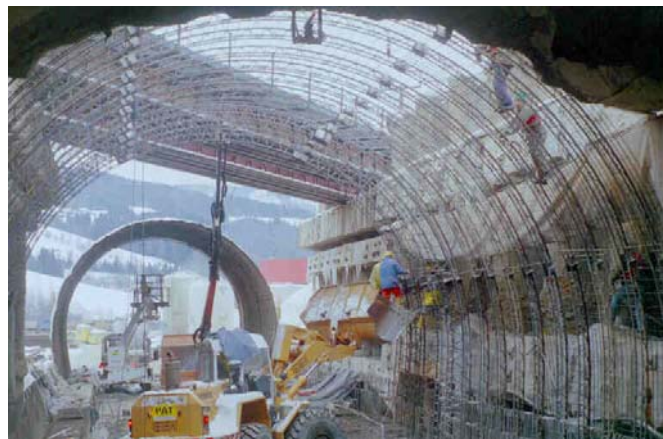
Komplexer Anfahrbereich mit Unterquerung der ÖBB-Südbahnstrecke (Bohrpfahlwände und Luftbogenstrecke)
